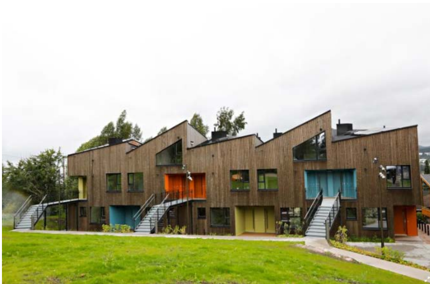
Boligprosjekt på Furuset, ved inngangsparti.
